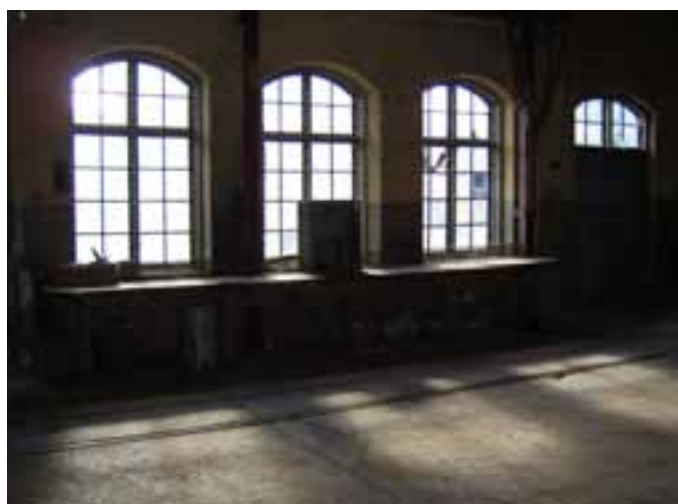
Interiör av reparationsverkstad.
