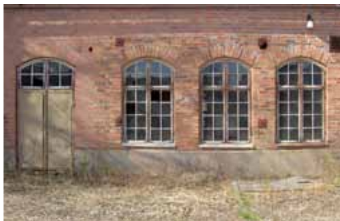
Östra fasaden av smedjan och reparationsverkstaden.
