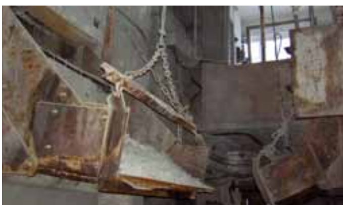
Tappfickor med fluster i södra verket.
