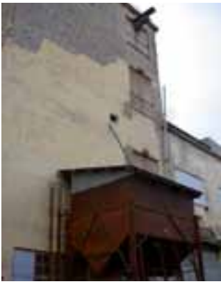
Exteriör av anrikningsverkets östra fasad.
