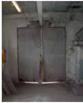
Interiör och telferanordning i anrikningsverkets tredje plan.
