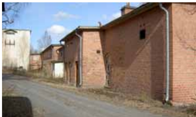
Smedjan och reparationsverkstadens västra långsida.
