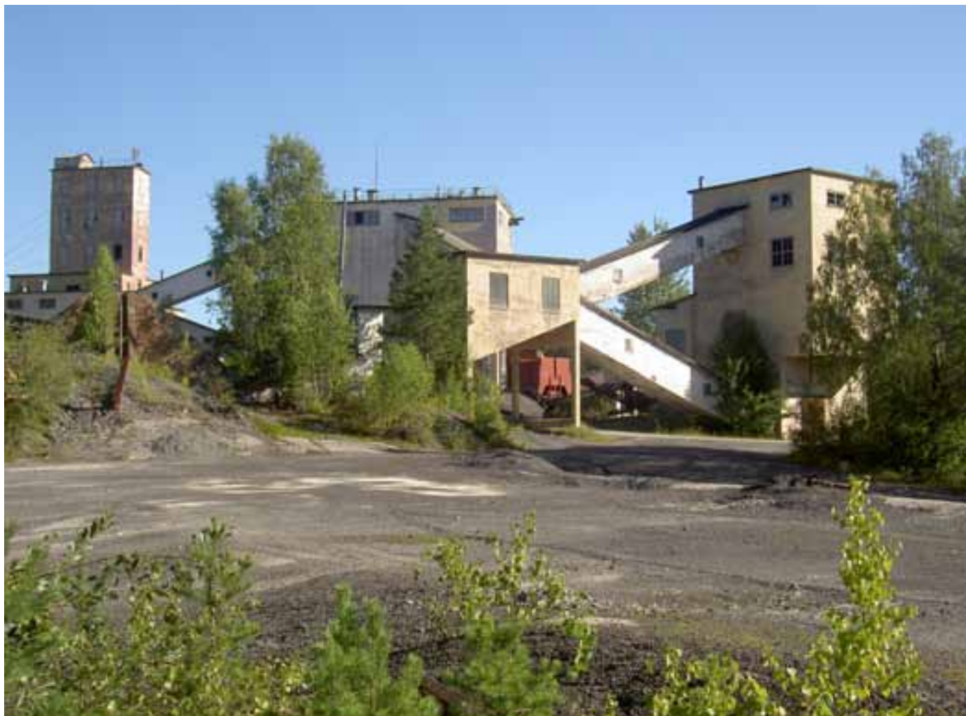
Gruvanläggningen från malmupplaget.
