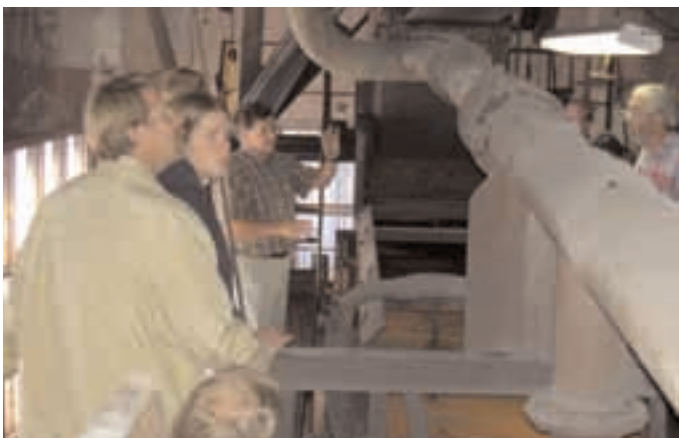
Sjunk- och flytanläggning (Svenssons ränna).
