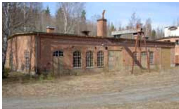
Östra fasaden av smedjan och reparationsverkstaden.
