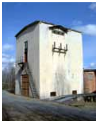
Transformatorbyggnaden från SV.
