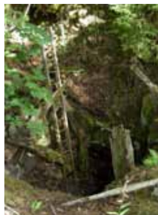
Schakt vid Norra smalgruvan.
